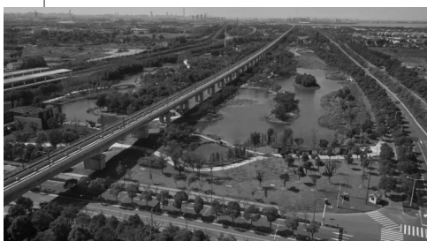
昆山高铁星溪公园有5个天安门广场那么大
